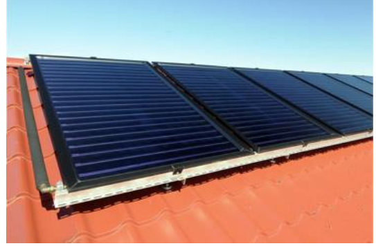
Yenilenebilir Enerji Kaynakları
